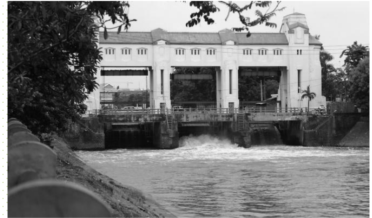
Gambar 3.7 Pintu air berfungsi untuk mengontrol aliran dan arus sungai dengan cara dibuka-tutup. Pintu air adalah contoh tindakan mitigasi kebencanaan banjir.
